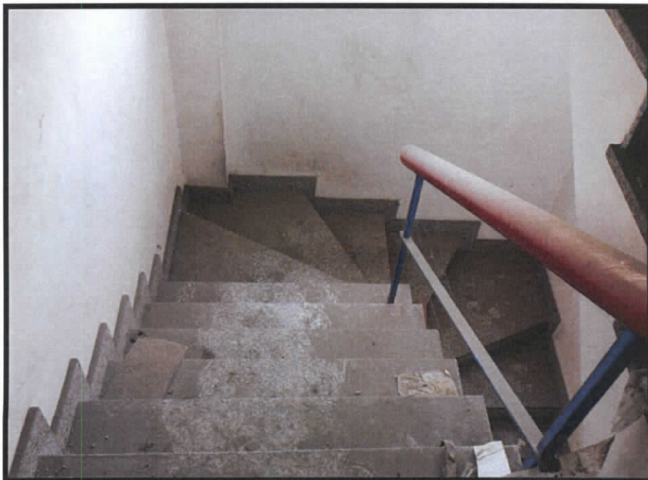
Figura 20 - HALL DA ESCADA
