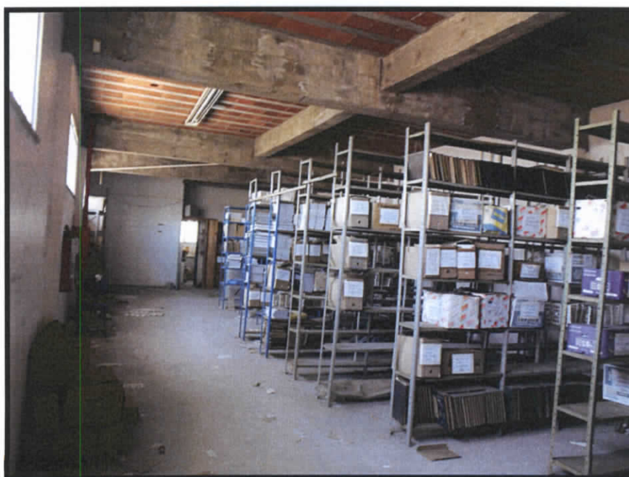
Figura 18 - VISTA PELOS FUNDOS DO AMPLO SALÃO
