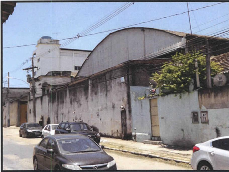
Figura 31 - ÁREA FRONTAL TOTALMENTE MURADA
