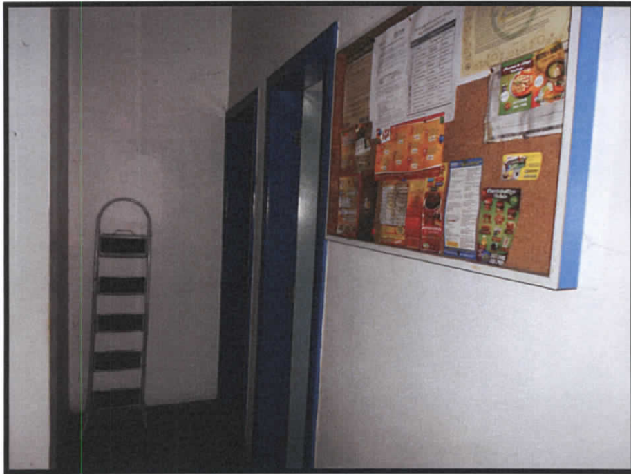
Figura 7 - CONJUNTO DE SANITÁRIOS
