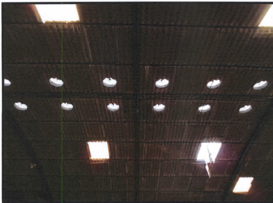
Figura 43 - VISTA DO TELHADO COM EXAUSTORES AEÓLICOS E TELHAS PLÁSTICAS TRANSLÚCIDAS
