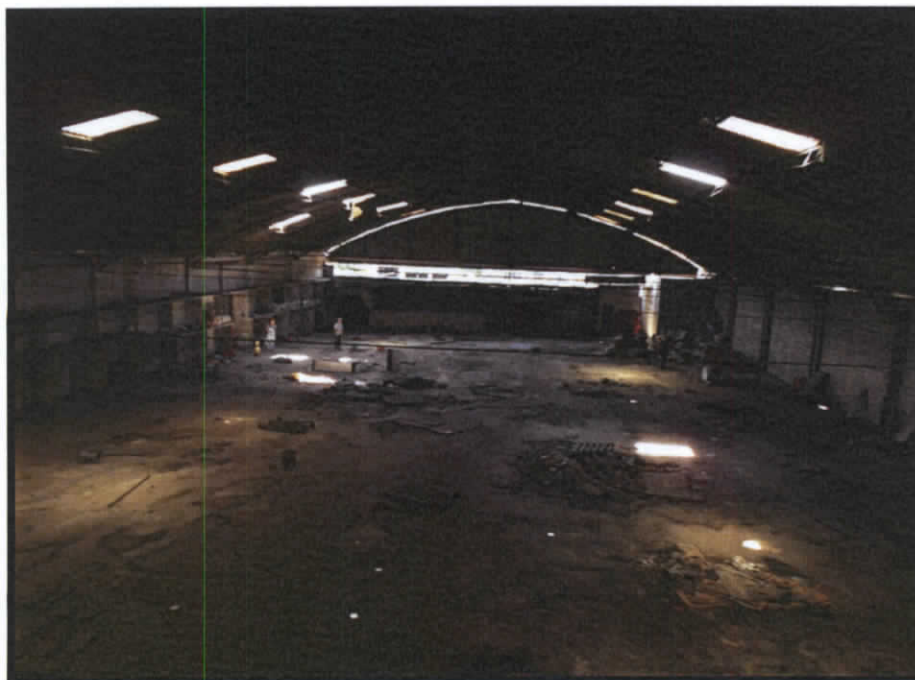
Figura 37 - VISTA INTERNA PELOS FUNDOS DO GALPÃO
