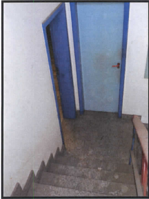
Figura 19 - HALL DA ESCADA
