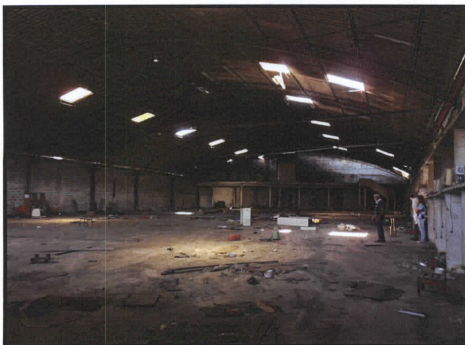
Figura 34 - VISTA INTERNA FRONTAL, LATERAL ESQUERDA DO GALPÃO
