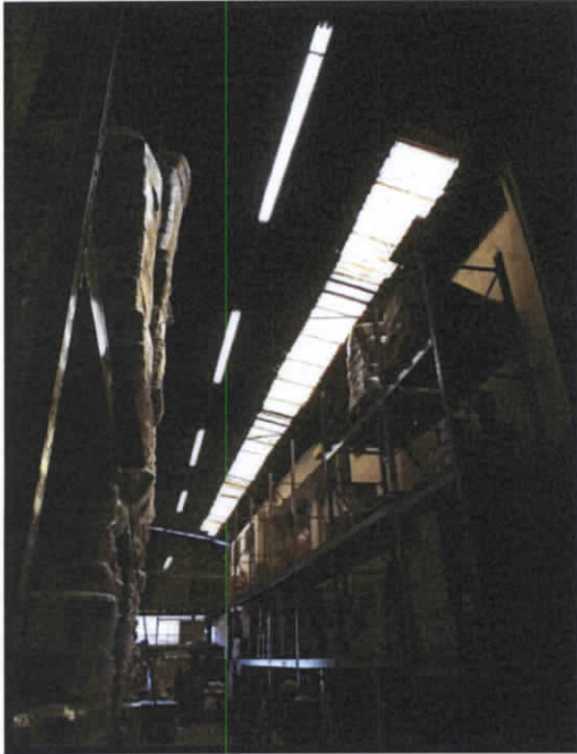
Figura 29 - VISTA INTERNA PELOS FUNDOS DO GALPÃO
