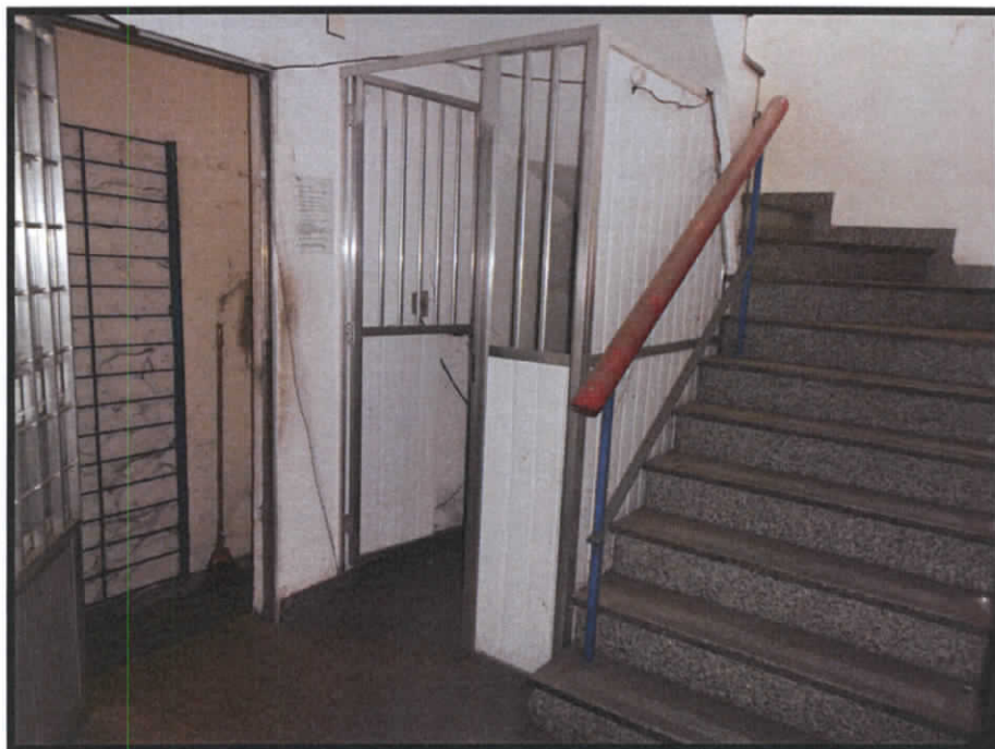
Figura 3 - HALL DA ESCADA
