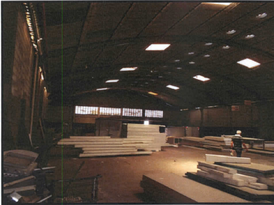
Figura 42 - VISTA INTERNA PELOS FUNDOS DO GALPÃO
