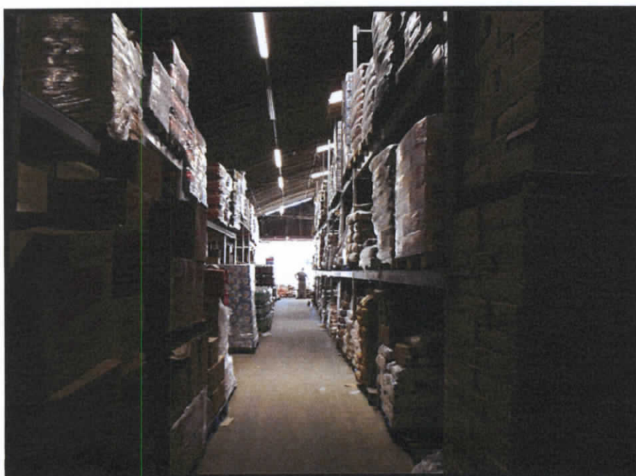
Figura 28 - VISTA INTERNA PELOS FUNDOS DO GALPÃO
