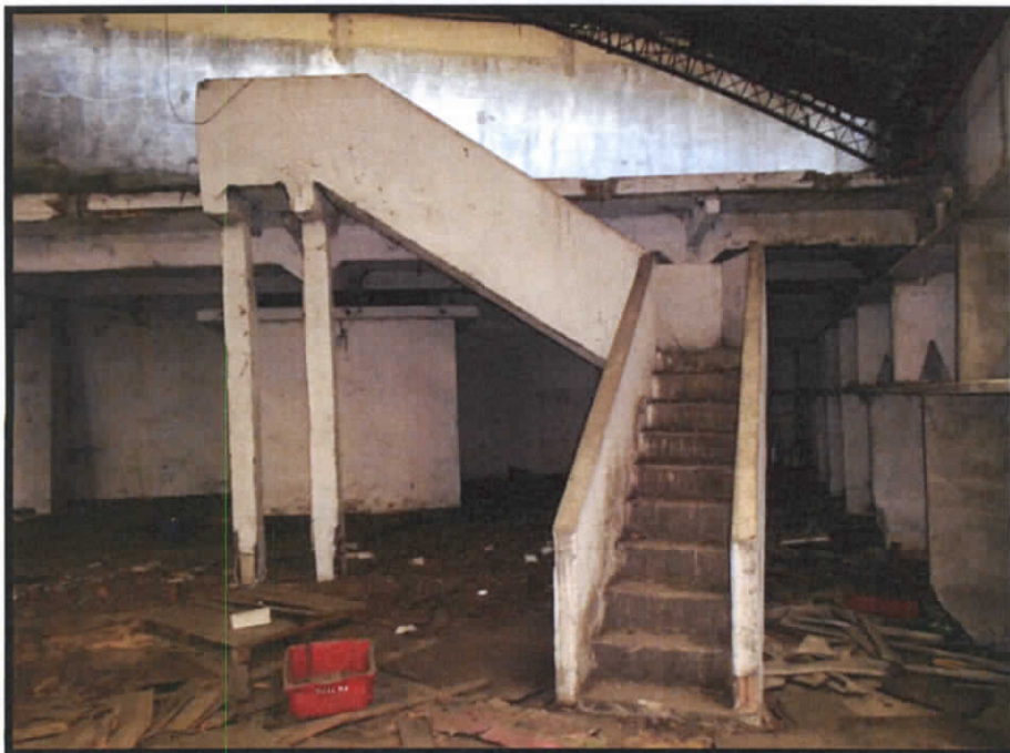
Figura 6 - ACESSO AO JIRAU
