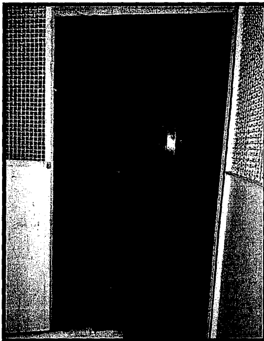
Figura 26 - CASA DE FORÇA
