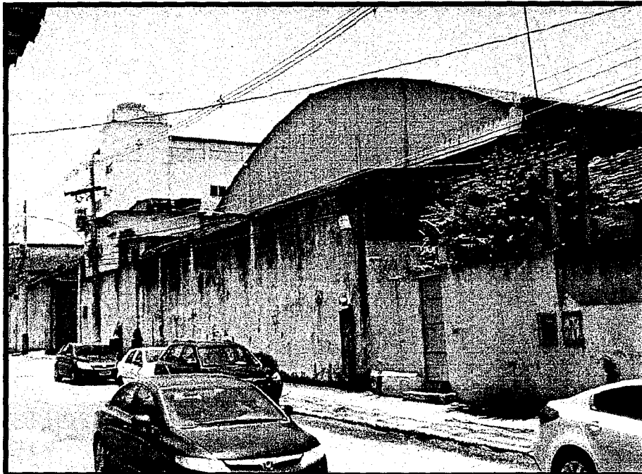
Figura 31 - ÁREA FRONTAL TOTALMENTE MURADA
