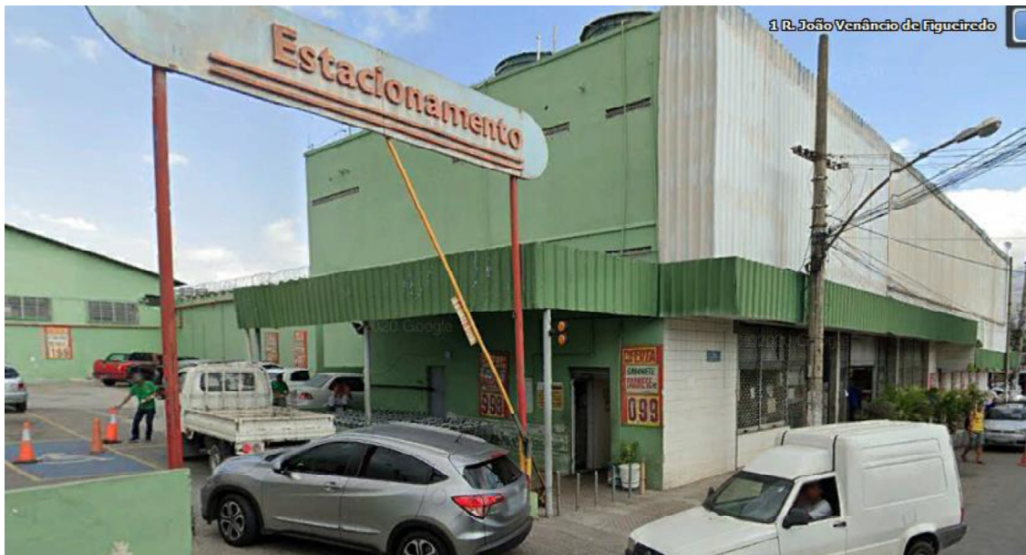
Figura 9 – Imóvel 4- Rua João Venâncio de Figueiredo,22 – Nova Iguaçu.
